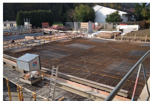
Decke über Tiefgarage
