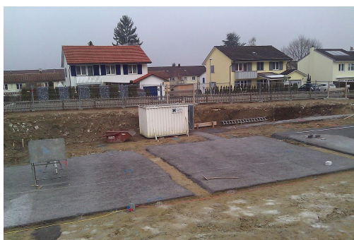
Baugrube und Fundation
