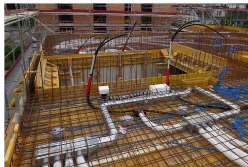
Bewehrung Decke 2.OG mit Einlagen
