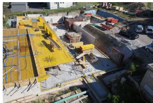
Baugrube und UG südlich Tiefgarage
