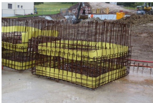
Bewehrung Liftunterfahrt vorgebunden
