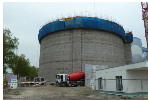
Gleitbetonbau
