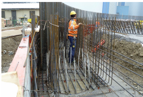
Bewehrung Bodenplatte
