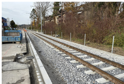
Neue Schotterfahrbahn
