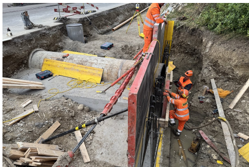
Erstellung Bachdurchlass Imbach
