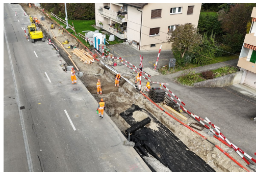
Erstellung Gleisunterbau- und Entwässerung
