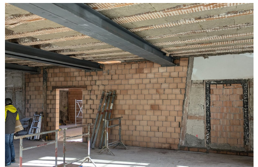
Einbau Unterzüge Bereich Klassenzimmer
