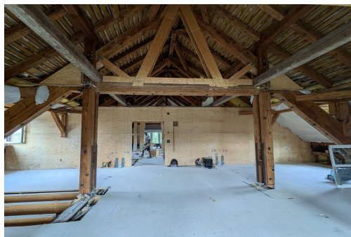
Dachstuhl Rohbauzustand vor Umbau
