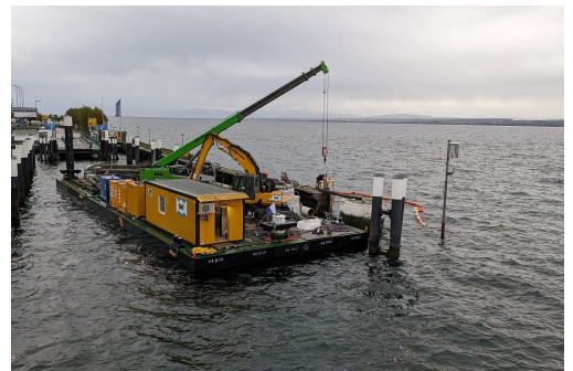
Abbruch Mole von Ponton aus
