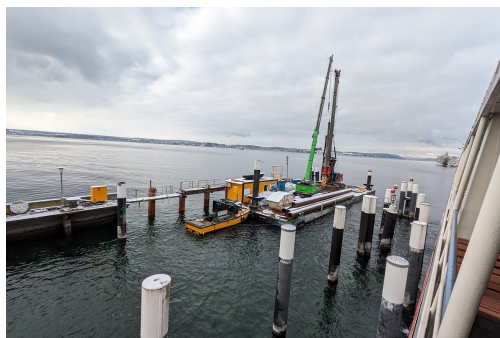
Ponton mit Bohrergerät
