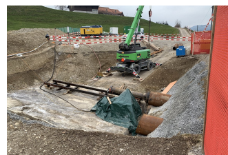
Startgrube Rammvortrieb Westrohre
