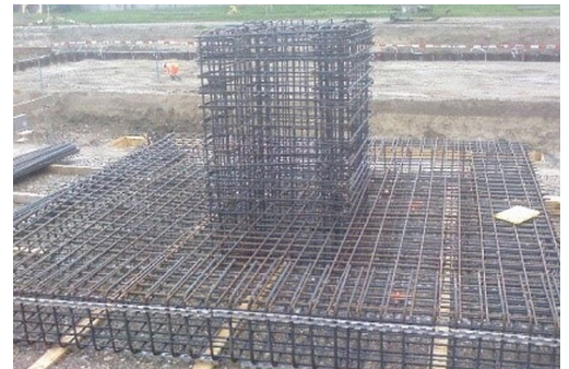
Köcherfundamente für vorfabrizierte Betonstützen
