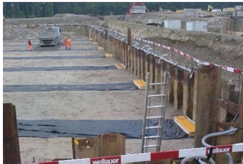
Baugrube, Voraushub und Spundwand
