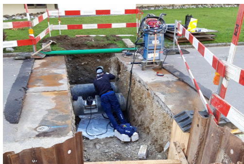
Anschluss an die Hauptleitung
