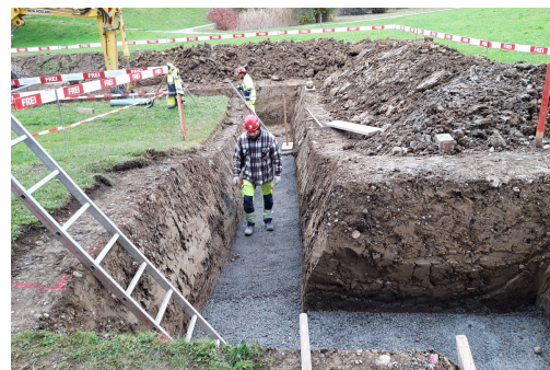
Magerbeton als Sauberkeitsschicht
