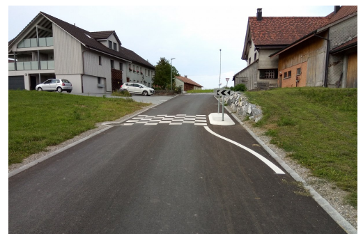
Neue Strassenmarkierung und bauliche Massnahme
