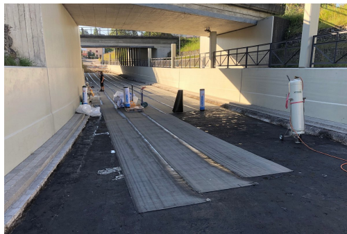
Abdichtung Unterführung
