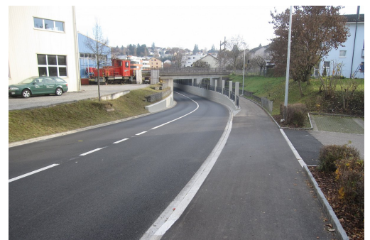
Langdorfstrasse nach der Sanierung
