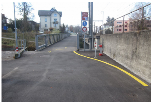
Eisenbahnstrasse als Langsamverkehrsrout
