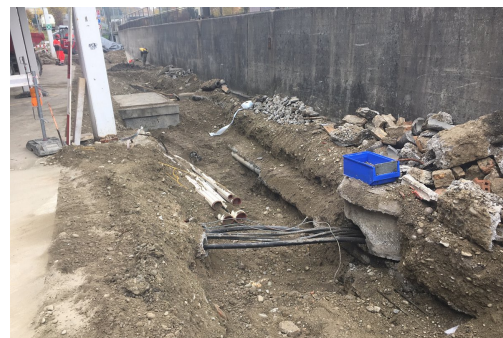
Werkleitungsbau bei engen Verhältnissen
