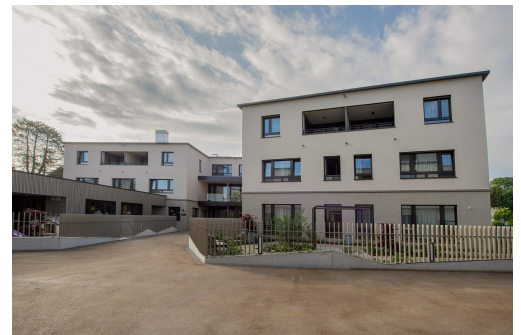
Ansicht Nord Haus A+B mit Stützmauer Demenzgarten und KiTa
