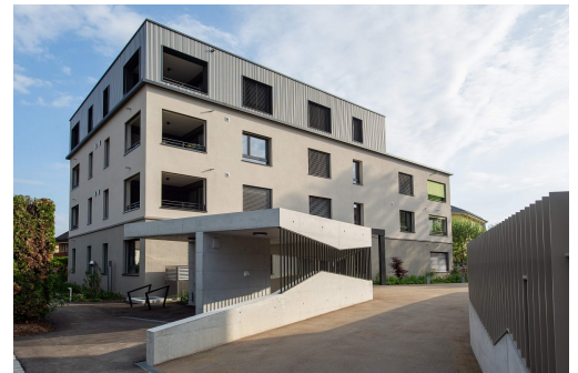
Ansicht Aussentreppe, Haus C
