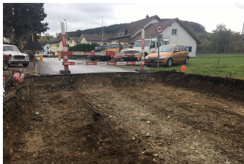
Einbau des Kieskoffers
