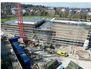
Neubau Hallenbad Frauenfeld
